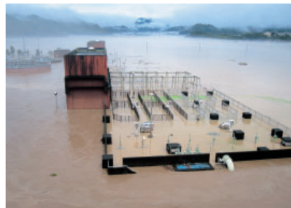
▶浸水した下水処理場 (人吉浄水苑)
